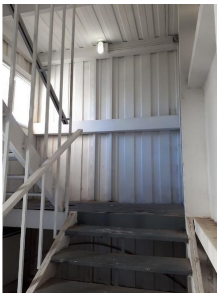
Fotografía n° 2 : Reparación Núcleo de escaleras.
