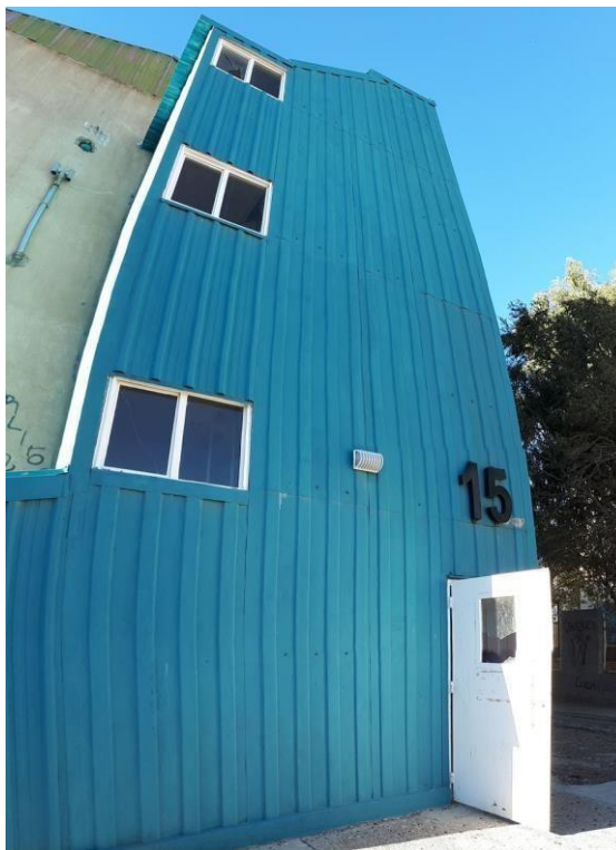
Fotografía n° 1 : Reparación Núcleo de escaleras.
