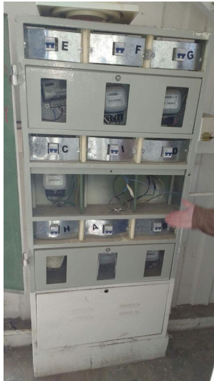
Fotografía n° 4 : Reparación Núcleo de escaleras (medidores).
