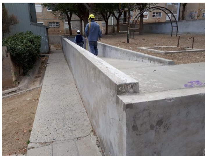
Fotografía n° 6 : Red peatonal y rampas.
