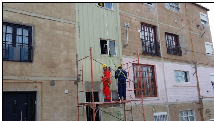
Fotografía n° 8: Reparación Núcleo de escaleras.
