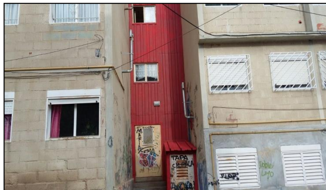
Fotografía n° 2 : Reparación Núcleo de escaleras.
