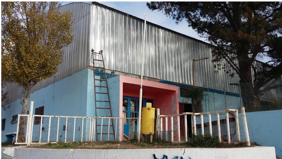
Gimnasio municipal en el sector, recuperado con fondos de contraparte municipal.
