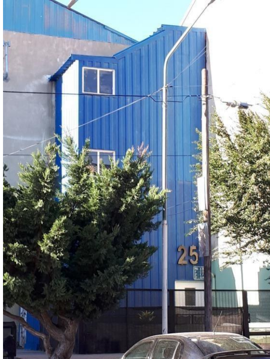
Fotografía n° 3: Reparación Núcleo de escaleras.
