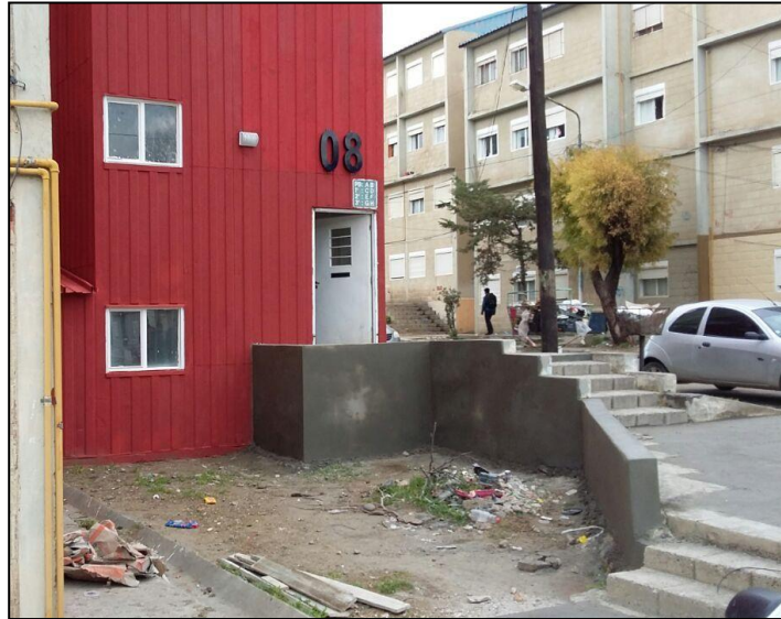
Fotografía n° 4 : Reparación Núcleo de escaleras y red peatonal.
