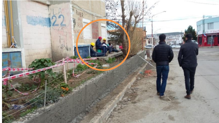
En visita de obras de 12/08/2017, se observó a los obreros sentados en la vereda del complejo, almorzando viandas propias.
